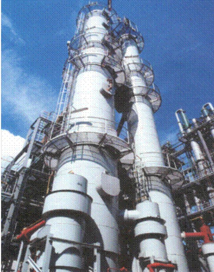
Destillationsanlage für Trichlorsilan
